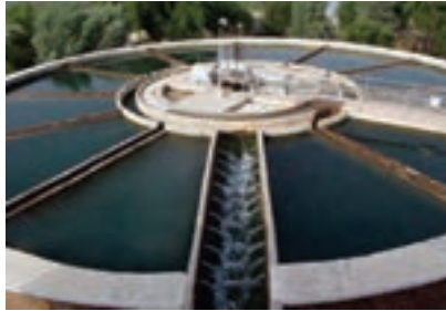
آب در تصفیه‌خانه
